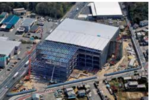
鉄骨・屋根工事施工状況
