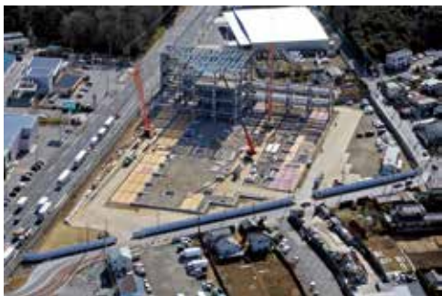
鉄骨建方工事施工状況
