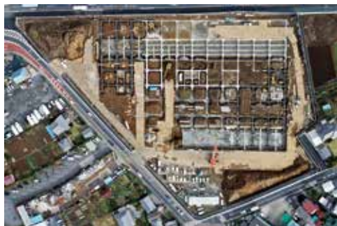
杭・基礎工事施工状況
